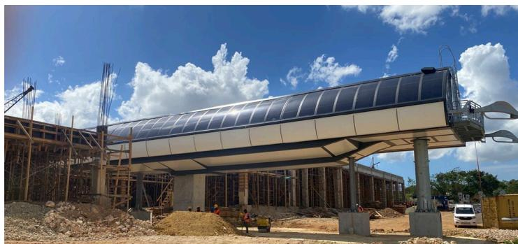
Componente electromecánico en el centro, Estación a la izquierda programada para vaciado de losa la semana entrante, a la derecha el garaje de cabinas en su fase de estructura completa.
